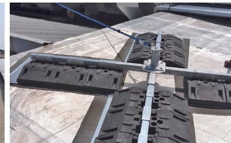
Problemi di foratura solaio
