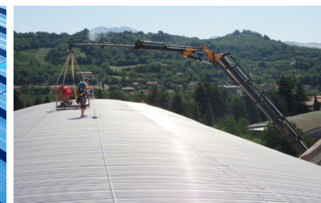
Installazioni in sicurezza tramite gru
